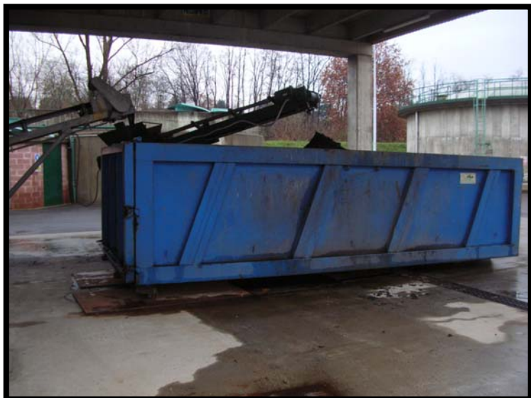
23 Scarico fango disidratato
