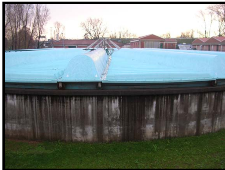
8 Sedimentazione primaria
