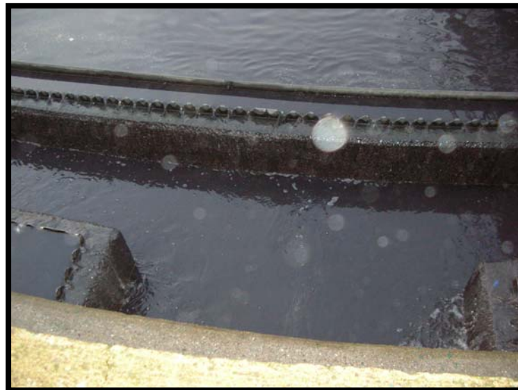
14 Stramazzo sedimentazione secondaria
