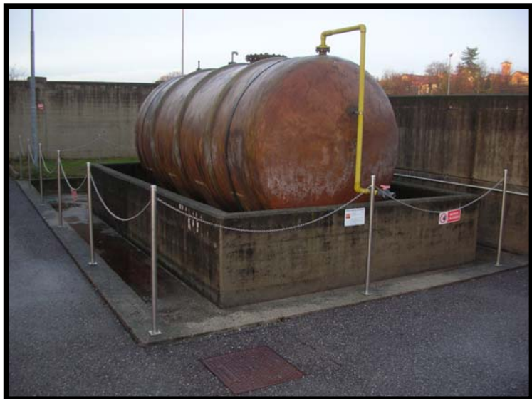
17 Serbatoio ipoclorito di sodio
