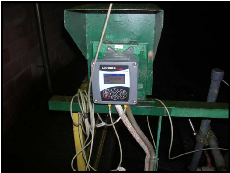
11 Misuratore ossigeno disciolto
