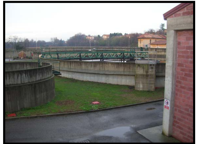
12 Sedimentazione secondaria
