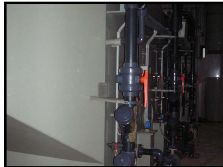
24 Sistema di depurazione aria ambienti coperti - scrubber
