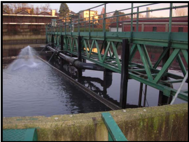
13 Sedimentazione secondaria
