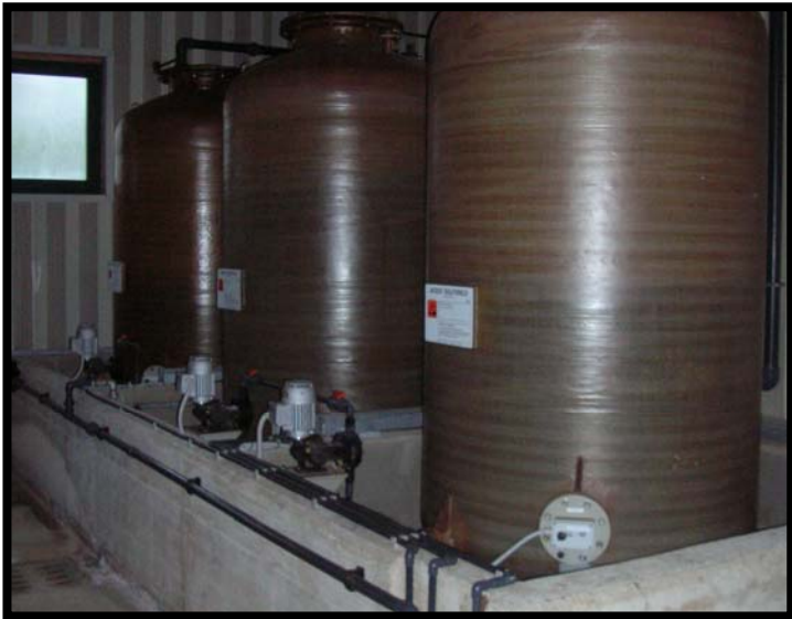
25 Reagenti sistema di depurazione aria ambienti coperti - scrubber
